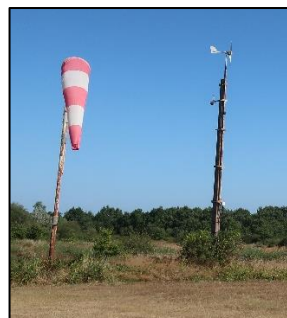
Mâts météorologiques au Sud Source : Artifex 2018
